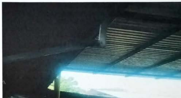
Foto 4: Sustrucción de canal de metal
