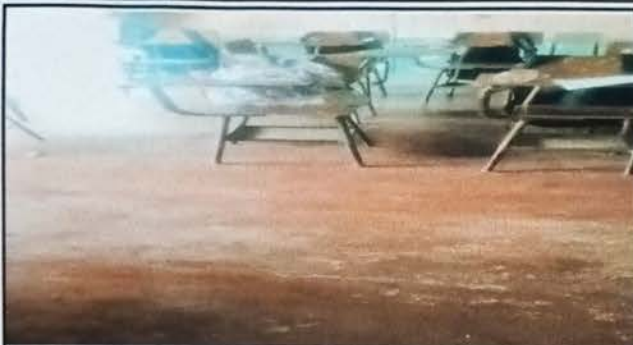
Foto1: Sustrucción de piso de cemento líquido
