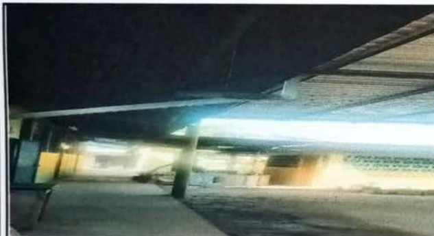
Foto 3: Sustrucción de canal de metal
