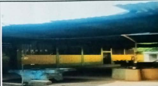
Foto 2: Sustrucción de lámina, por lámina acanalada aluzinc calibre 26
